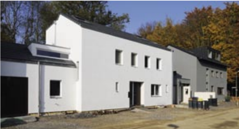
Bild 2: Ertüchtigtes Bestandsgebäude in Köln-Junkersdorf
