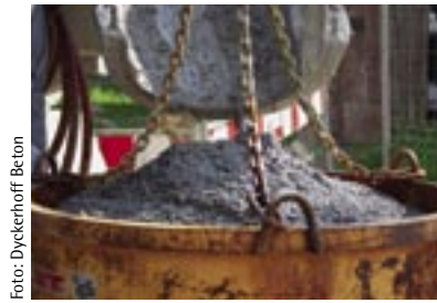
Bild 17: Der Leichtbeton mit Blähton-Gesteinskörnung bei Anlieferung auf der Baustelle
