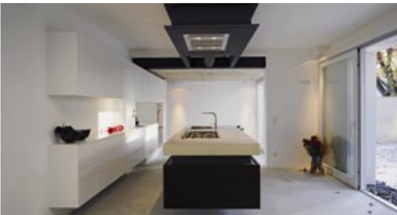
Bild 15: Küchenblock aus Sichtbeton
