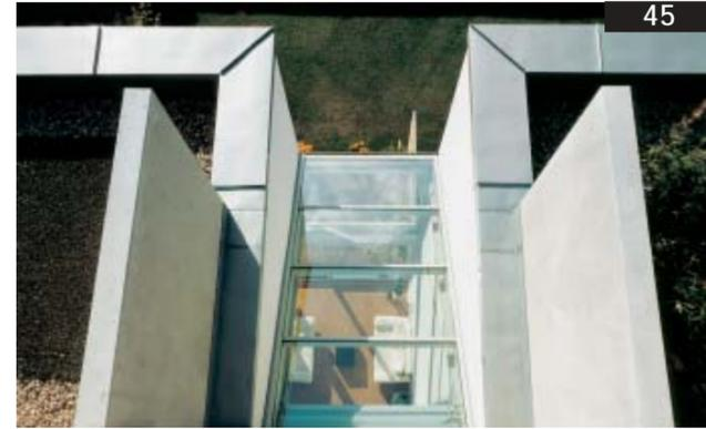
Ein überkopfverglastes, zweigeschossiges Atrium verbindet beide Geschosse und filtert Licht bis tief in den Innenraum
