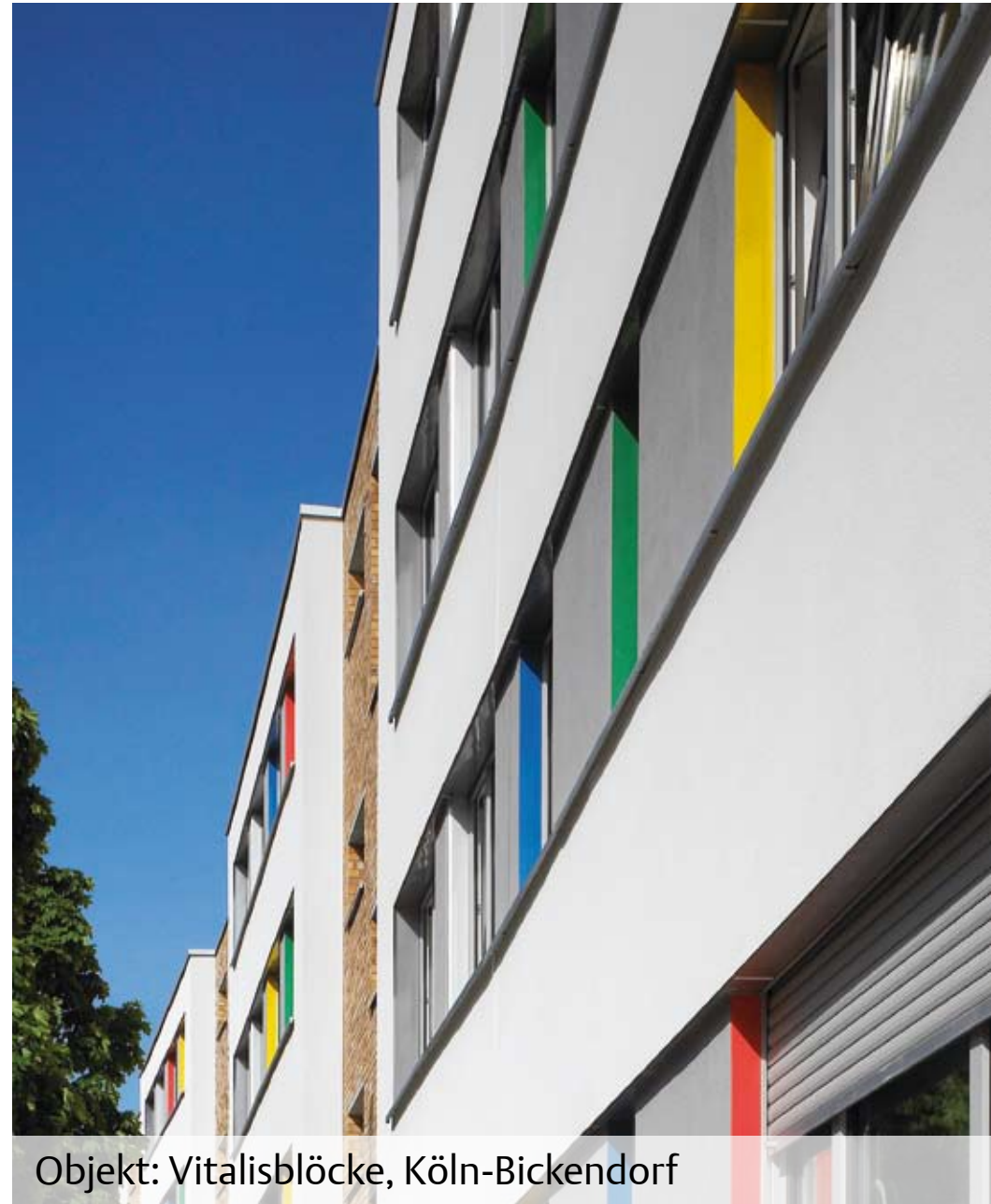
Objekt: Vitalisblöcke, Köln-Bickendorf
